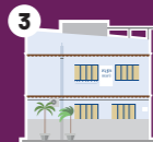
Administrativo Redes da Maré
