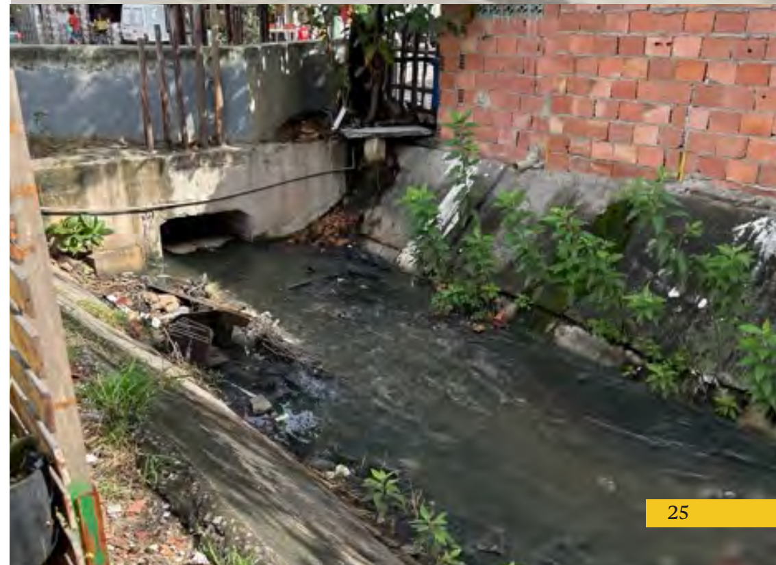
Infraestrutura de Drenagem e Recapeamento. Fonte: Pacto RJ 2023
